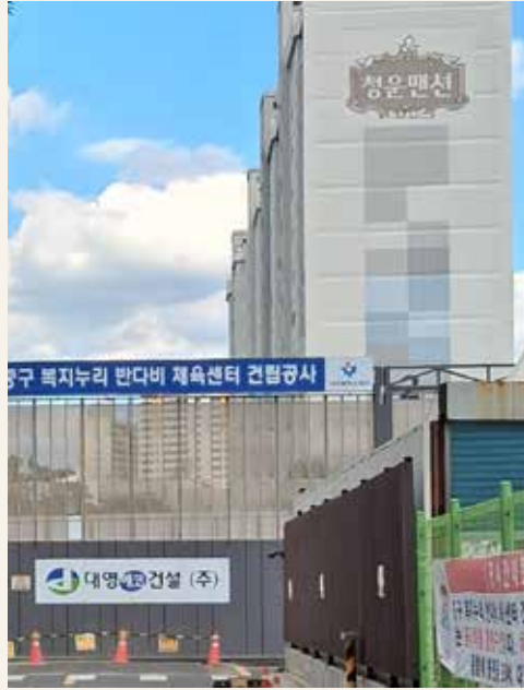
〈사진 4〉 복지누리 반다비 체육센터 공사 현장
